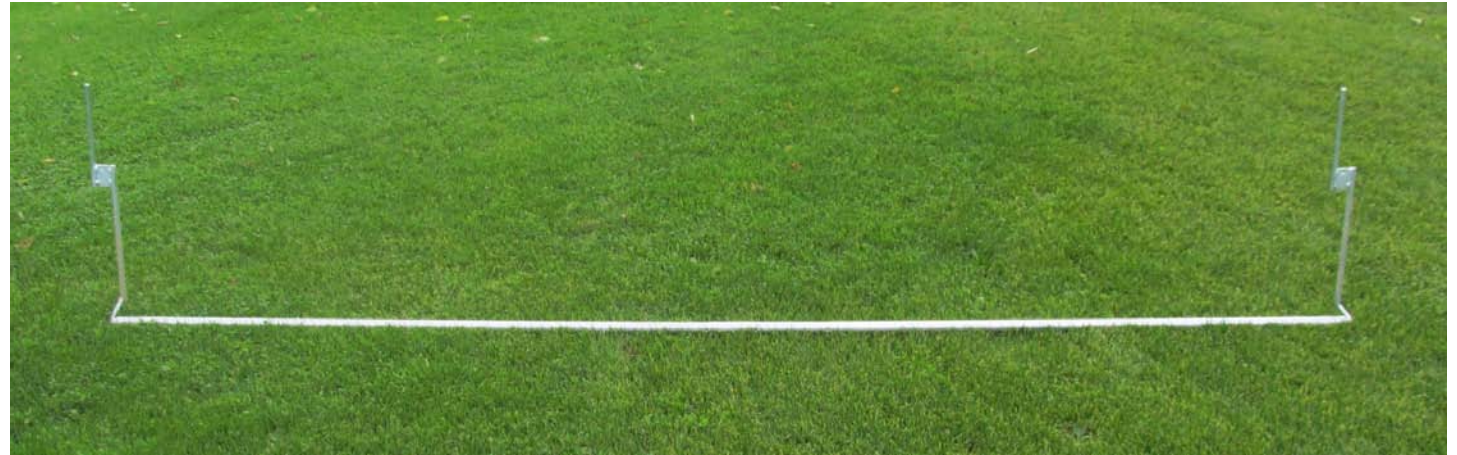
2. Die oberen Querrohre zusammen stecken und am Montageort hinlegen (definiert den Abstand für die Bodenanker)
